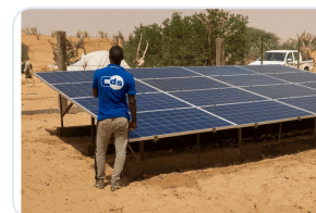
Pompage hybride — Tiguent
