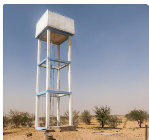
Château d'eau · Koubenni
